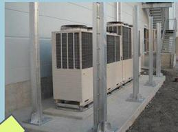
室外機を防音パネルで覆って空調機の排気による騒音を解消。
